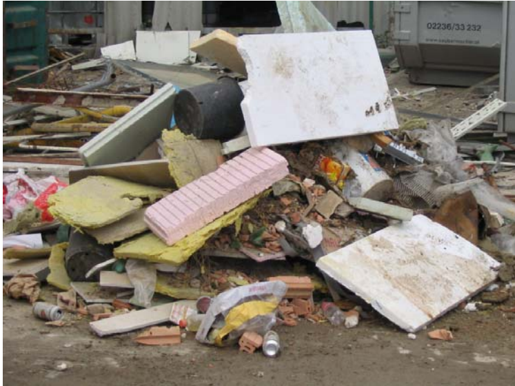
Abbildung 1: Gemischte Baustellenabfälle in Wien (v.a. sperrige Bestandteile) (PLADERER et al, 2004)
