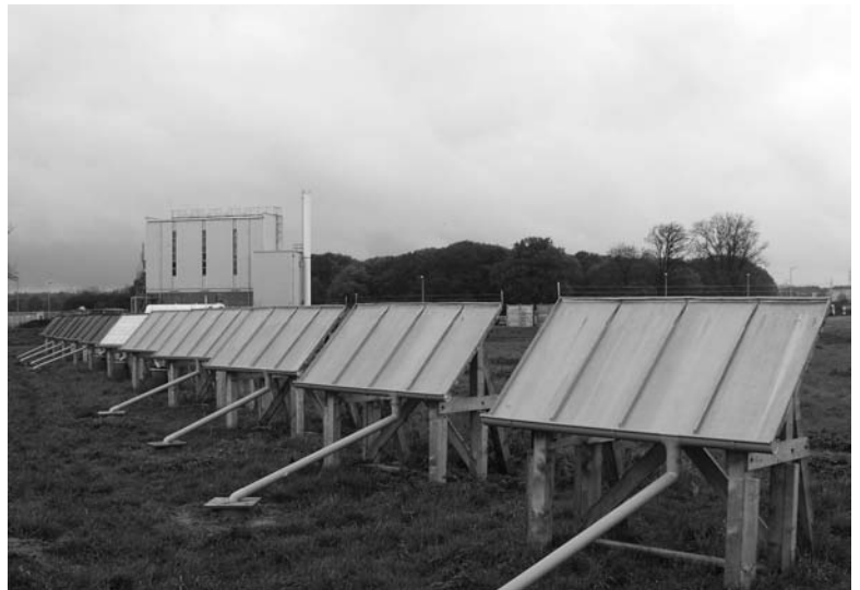
Abb. 1: Feldversuch nach Anschluss der Dachabläufe an die Sickerschächte
