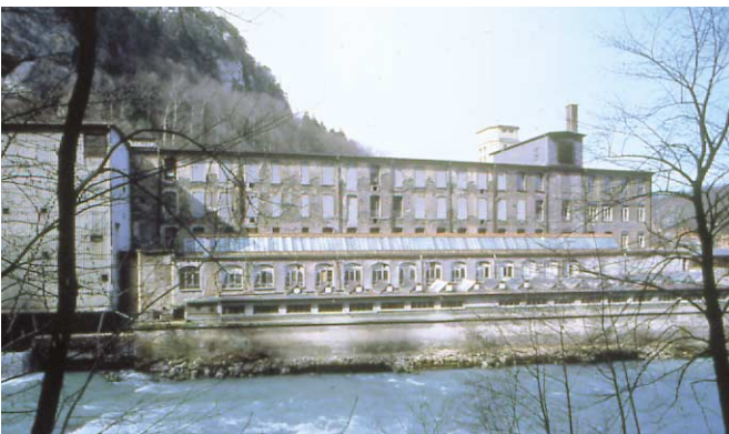
Sanierung einer ehemaligen Textilfabrik in Feldkirch/Vorarlberg, Südfassade vorher – nachher (Planung Edda Mally)
