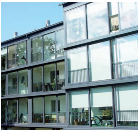
Abb. 4: Verglaste Balkone Sanierung mit PH-Komponenten in Dornbirn, Arch. Kuess
