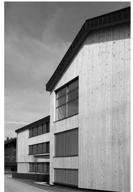
Abb. 2: Sanierung „Hauptschule Bezaun“ (Quelle: Bereuter, 2008)
