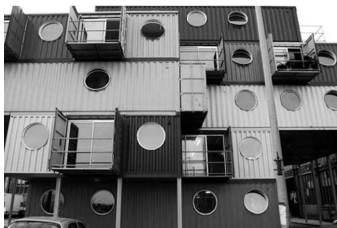
Abbildung 3: „Container City“, 2002, London/ Urban Space Management Ltd. Quelle: http://tecnoarquitectura.com/?attachment_id=1246
