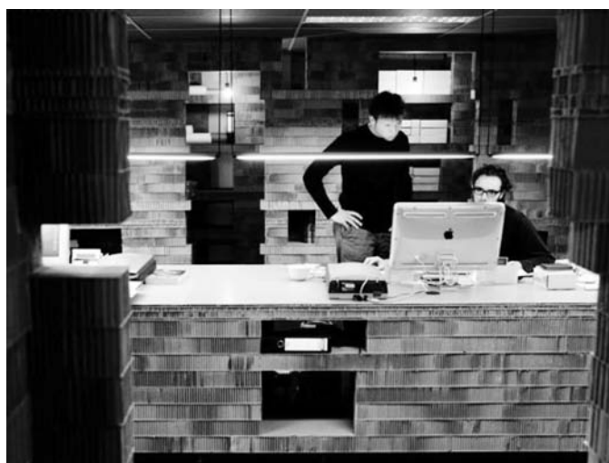
Abb. 4: Von Ro&Ad Architekten wurde das Interieur eines Grafikbüros in Eindhoven gestaltet. Arbeitstische, Regale und Trennwände bestehen komplett aus Karton-Waben-Platten mit einer Dicke von ein bis zwölf Zentimetern. Dieses Beispiel ist im Rahmen dieses Forschungsprojekts weniger wegen der besonderen Kreislauffähigkeit von Karton interessant, sondern aufgrund der Reduktion vieler Anforderungen auf ein Material und die einfachen Umgestaltungsmöglichkeiten, welche besonders für temporäre Nutzung wie im vorliegenden Bürobeispiel interessant sind.
