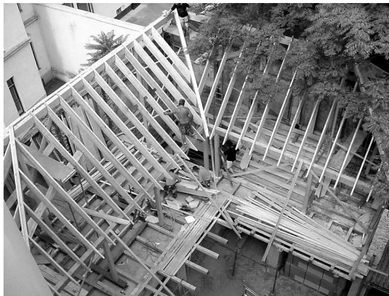
Bilder einer Baustelle
