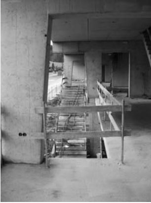
Tragsystem: Querliegende Stahlbetonscheiben
