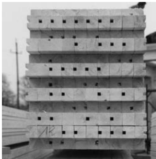
Brettstapeldecke mit Nut- und Feder- verbindung
