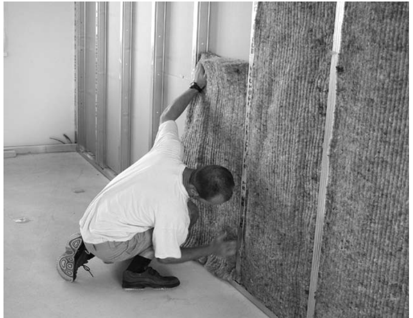
Abbildung 1: Einbau von ISOLENA Klemmfilz
