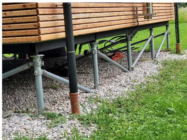
Abbildung 8: Schraubfundamente, unverbaut (links), Quelle: [www.baubiologie.at](http://www.baubiologie.at)
