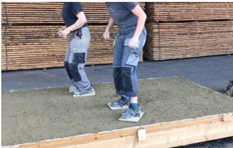
Abbildung 52: Außenwandbauteil - Verdichtung des Lehms mit Holzplatten (Quelle: Mag. Andreas Breuss MSc)
