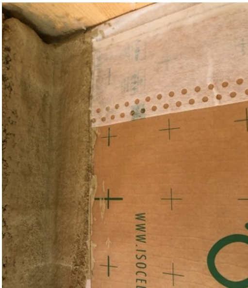
Abbildung 57: Bauteilanschluss HLV und Dampfbremse synthetisch (Quelle: Mag. Andreas Breuss MSc)
