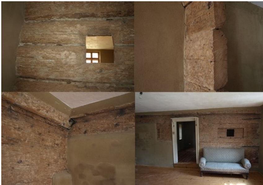
Abbildung 50: Holzblockwand eines ca. 600 Jahre alten Hauses im Weinviertel (Quelle: Mag. Andreas Breuss MSc)
