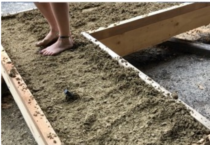
Abbildung 53: Außenwandbauteil - Verdichtung des Lehms barfuß (Quelle: Mag. Andreas Breuss MSc)
