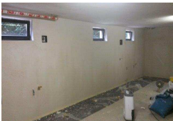
Abbildung 21: Kellerwand nach Aufbringen des Grundputzes
