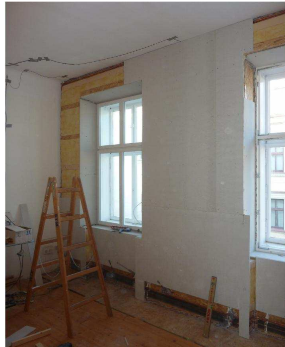
Abbildung 30: Beplankung der Installationsebene
