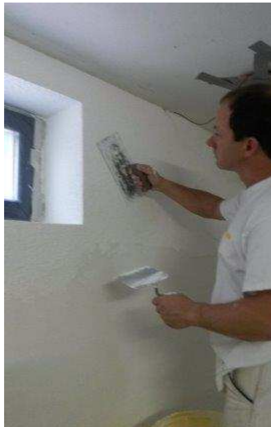
Abbildung 28: Aufbringen der letzten Putzschicht des Innendämmsystems
