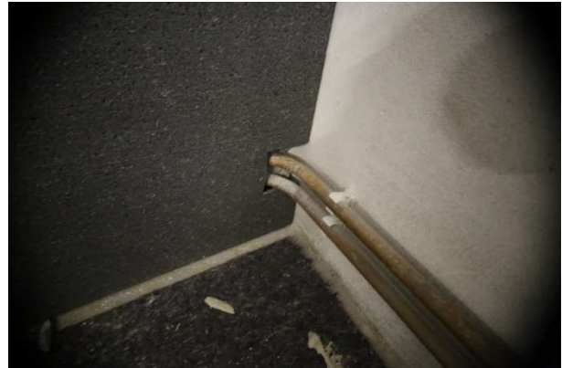
Abbildung 18: Detail Heizungsrohre und Innendämmung
