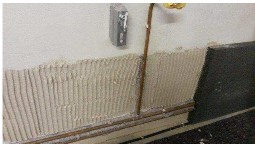
Abbildung 1: Aufbringen der Dämmplatten, Konsole für spätere Heizungsanlage. Demonstrationsprojekt aus dem Forschungsprojekt IDSolutions, Dämmsystem und Ausführung Projektpartner Sto Ges.m.b.H
