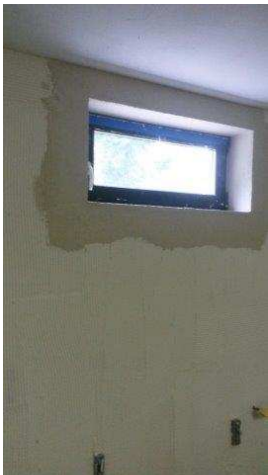
Abbildung 12: Fenstertausch und Vorbereitung der Leibung
