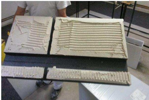
Abbildung 19: Dämmplatte mit Kleberschicht, für Heizungsrohre ausgeschnitten.
