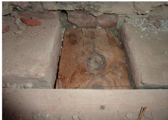
Abbildung 33: im Zuge der Sanierungsarbeiten freigelegter Balkenkopf
