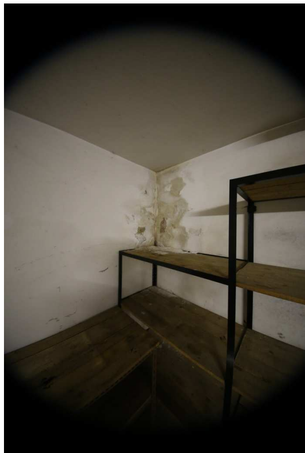
Abbildung 7: Feuchteschaden durch eindringendes Oberflächenwasser.
