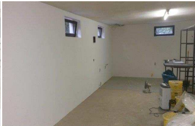
Abbildung 20: Keller nach Fertigstellung der Innendämm-Maßnahme.
