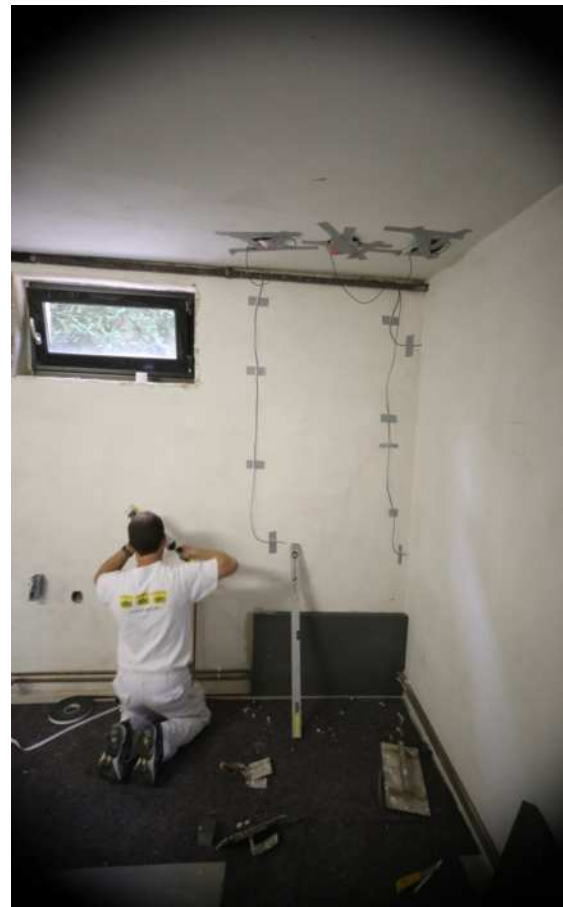
Abbildung 24: Applikation der ersten Dämmplatten, Mess-Sensoren positioniert, Kabel werden im Deckenbereich hinter der Dämmung herausgeführt.
