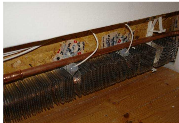
Abbildung 32: Heizleiste, Durchführung der Kabel der Balkenkopfheizung durch die Dampfbremsebene
