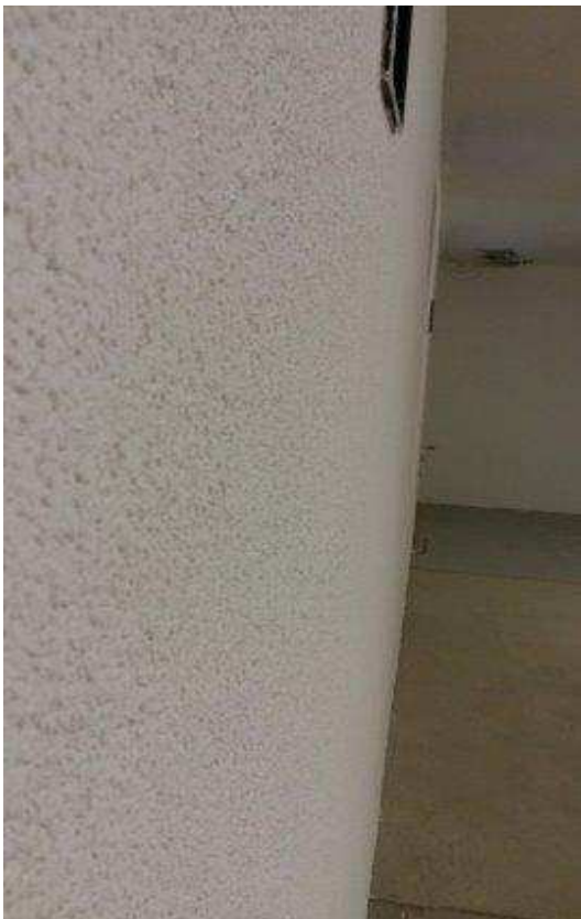
Abbildung 27: Oberflächenfinish des Innendämmsystems
