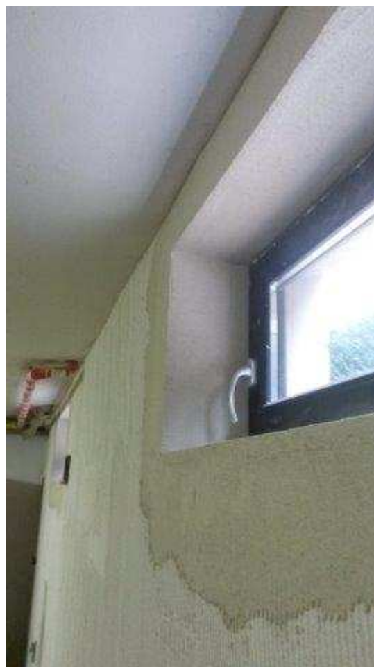
Abbildung 13: Glattnstrich im Bereich der Fenster
