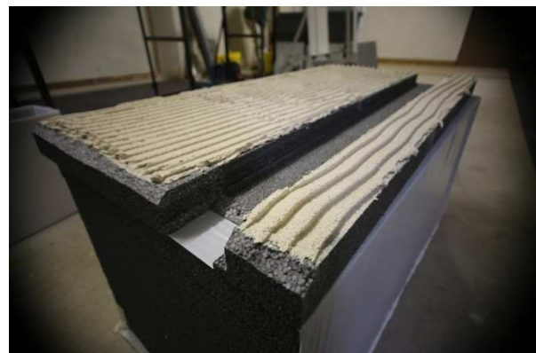
Abbildung 16: Dämmplatte für Heizungsrohre ausgeschnitten.
