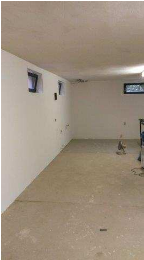
Abbildung 23: Sanierungsobjekt nach Fertigstellung der Innendämmung
