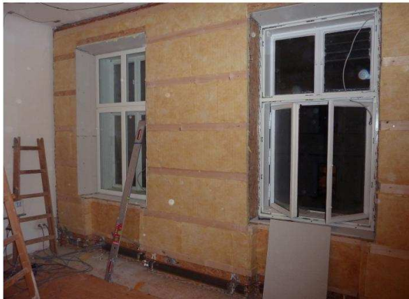
Abbildung 29: Fertigstellung Mineralwolle-Dämmung der Installationsebene
