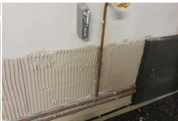
Abbildung 22: Aufbringen der Klebeschicht im Bereich der Heizungsrohre
