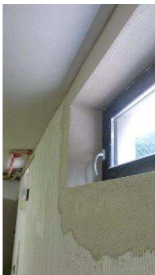
Abbildung 2: Vorbereitung des Untergrunds im Fensterbereich, Demonstrationsprojekt aus dem Forschungsprojekt IDSolutions, Dämmsystem und Ausführung Projektpartner Sto Ges.m.b.H
