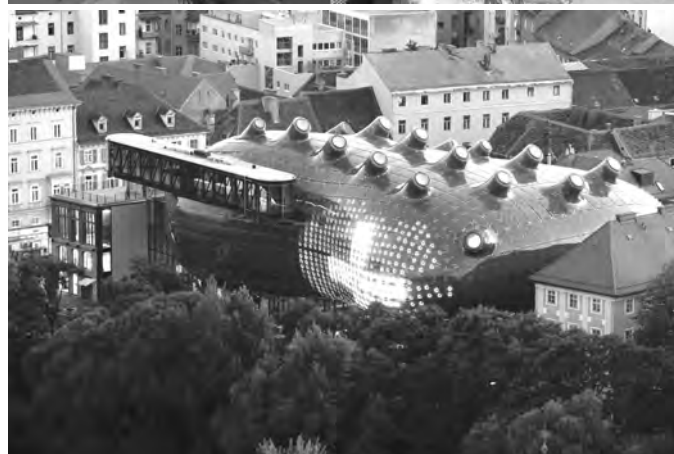
Referenzobjekte: Les Diablerets (CH) – Glacier 3000 (oben); Unter Acrylglas ein Dämmstoff, der sich jeder Form anpasst. „Polarskin“ aus FOAMGLAS® für den Vollwärmeschutz des Kunsthaus Graz, Quelle Foamglas®
