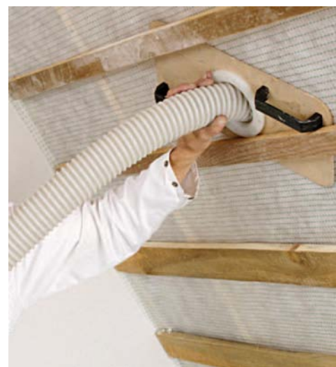
Abb. 2: Einblasvorgang des Zellulosedämmstoffs Thermofloc
