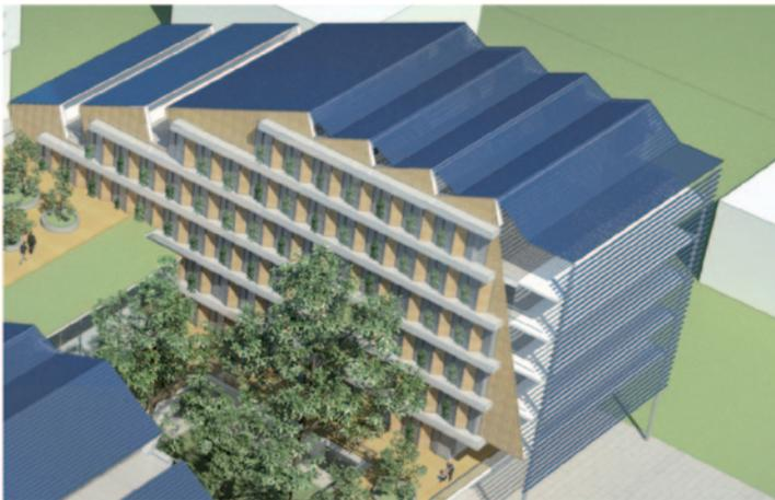
Abb. 5: Integration von Vakuümrohrenkollektoren in Südfassade (Quelle: FUTUREbase Endbericht, 2012)
