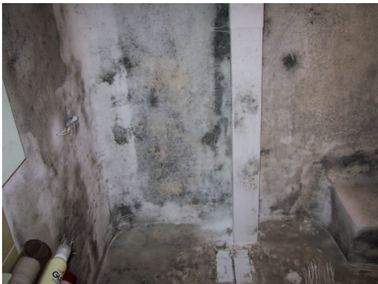
Massiver Schimmelpilzbefall in einem Badezimmer
