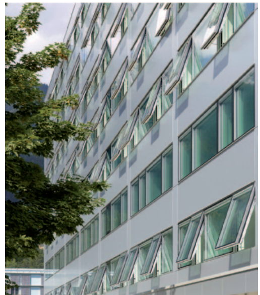
Abb. 1: Fassade mit Senk-Kipp-Verbund-Fenster Quelle: ATP/Thomas Jantscher
