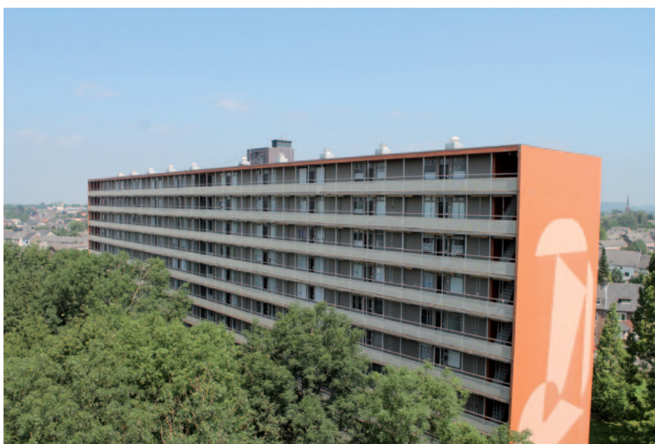
Abb. 2: Gebäuderiegel – Gebäude aus den 60er Jahren, Sozialer Wohnungsbau, Heem Wonen Wohnbauagentur
