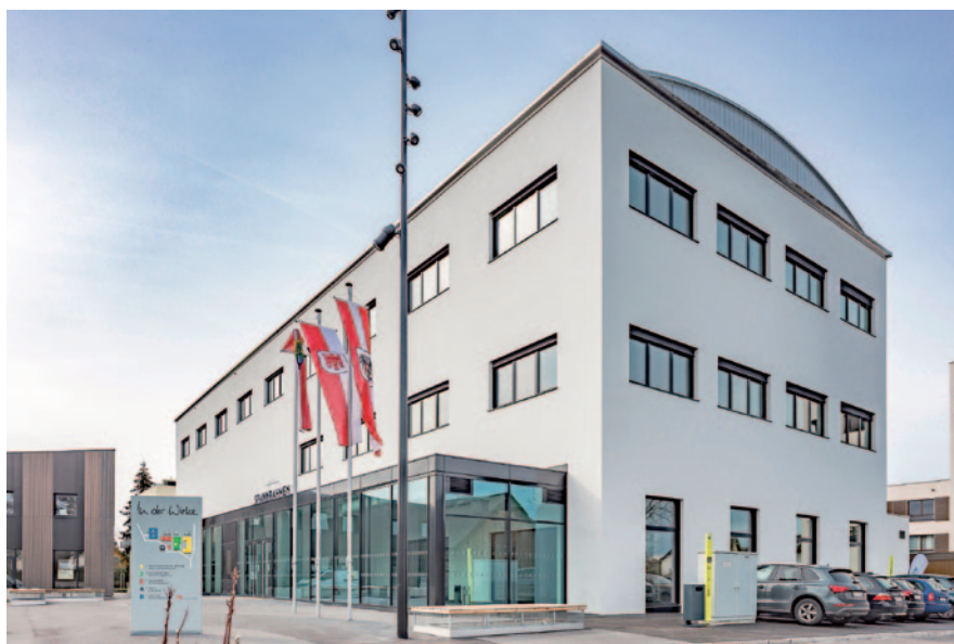
Vom hässlichen Werksgebäude zur modernen und ressourcen-schonenden Event-Location – mit einer Fassadendämmung aus Hanffasern. Foto: Synthesa
