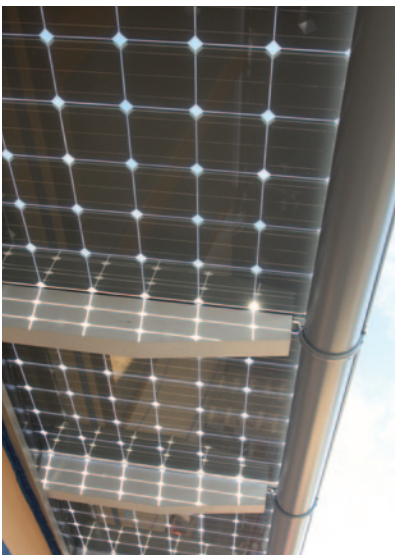
Vom Eingangs- und Wartebereich führt eine Stiege in das Obergeschoß zur VIP-Lounge und den Ordinationsräumen. Die Module der Fotovoltaikanlage sind im Traufenbereich montiert von unten sichtbar und dienen der Beschattung. Fotos ©: Schuller, ATOS Architekten
