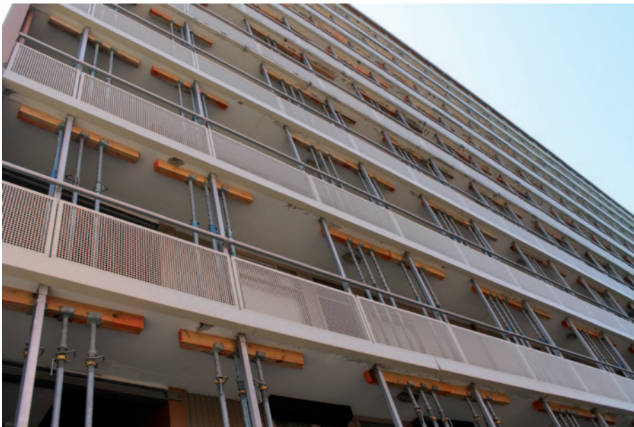
Abb. 3: Fassade mit Stützen
