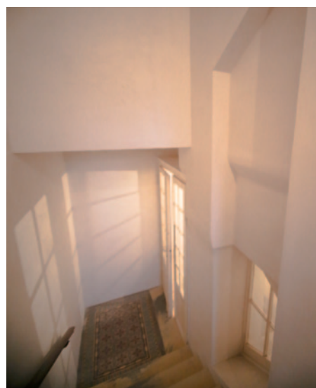
Abb. 2: Übergang zum unbeheizten Stiegenhaus
