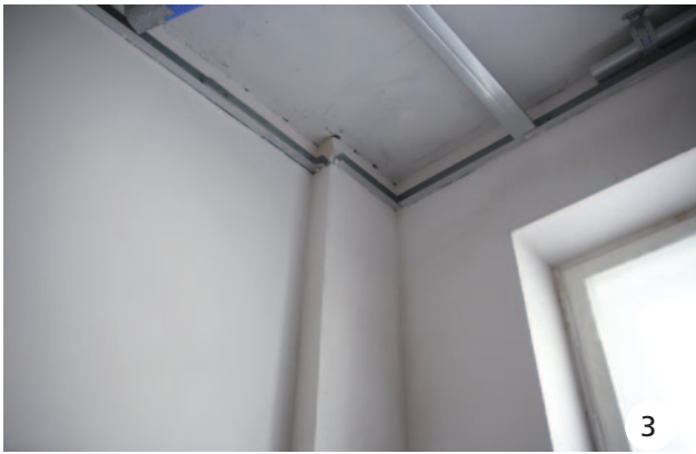
Abb. 3: Flankendämmung Innenwand und Ecke
