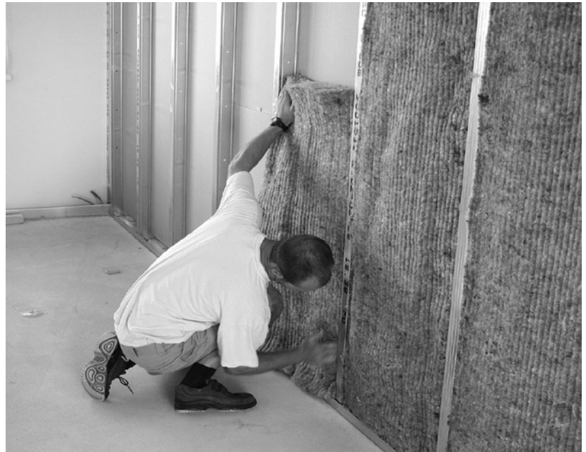
Abbildung 1: Einbau von ISOLENA Klemmfilz
