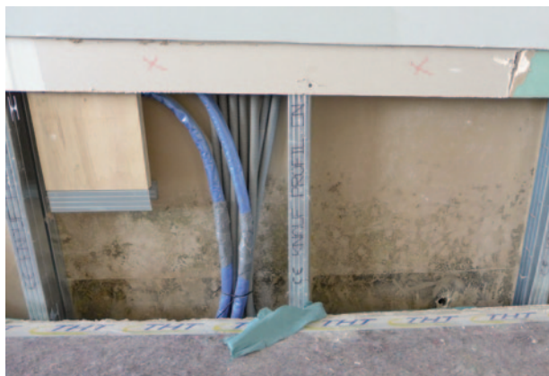
Abb. 1: Großflächiger verdeckter Schimmelbefall auf der Innenseite einer Gipskarton-Leichtbauwand, dessen Existenz und Ausmaß erst durch eine Bauteilöffnung sichtbar wurde.
