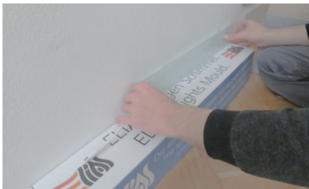
Abb. 5: Anbringen der Heizelemente
