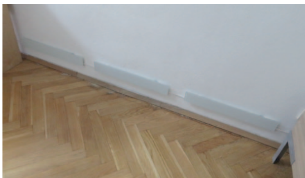
Abb. 4: Infrarotheizelemente zur Temperierung kritischer Bereiche der Feuermauer
