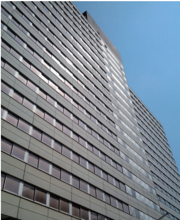
Abb. 1: Eines der vor dem Abbruch untersuchten Gebäude in Wien
