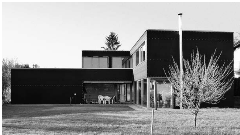
Abb. 7: Das ungewöhnlichste Merkmal des Haus Längle-Ess von Architekt Walter Unterrainer ist die textile Fassade aus winddichtem und witterungsbeständigem Industriegewebe aus Polyethylen. Die Holzrahmenbauweise unterstützt durch ihre Trennbarkeit jedenfalls die Kreislauffähigkeit von Gebäuden. Inwieweit die eingesetzten Materialien recycelbar sind, ist im Detail zu betrachten. Polyethylen ist gut recycelbar. Die Beanspruchung aus der Nutzungsphase (Gebrauchsspuren, Verschmutzung, Verklebung) steht häufig einer Wiederverwendung entgegen. Polyethylen wird derzeit vorwiegend stofflich verwertet.
