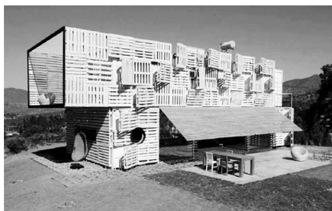
Abbildung 2: Casa Manifesto, Curacavi, Architekten James und Mau/ Infiniski, Curacavi/ Madrid. Drei Überseecontainer bilden die Tragstruktur des Wohngebäudes. Eine Längsfassade ist mit ehemaligen Transportpaletten verkleidet, die sich wie Klappläden öffnen und schließen lassen. Die Innendämmung der Container wurde aus recyceltem Zeitungspapier hergestellt; Treppen und zahlreiche Möbel bestehen aus Recyclingholz. Quelle: http://www.archdaily.com/41001/manifesto-house-james-mau-for-infiniski/ Foto: © Antonio Corcuera
