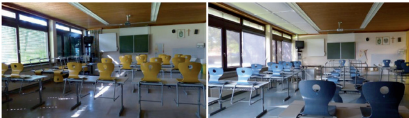
Abb.10: Sanierung von vier Klassenzimmern mit unterschiedlichen Beschattungs- und Tageslichtkonzepten. Bild li. Bestand: wenig Tageslicht, teilweise Direktblendung, tw. fehlender Sichtbezug, keine Bedienungsanleitung. Bild re. nach Sanierung (Konzept A): höhere Tageslichtautonomie, gleichmäßigere Belichtung, Sonnenschutz automatisiert, Blendschutz bedarfsgerecht einstellbar, besser Außenbezug, gebilderte Funktions- und Bedienungsanleitung auf 2 A4-Seiten. (HdZ-Projekt „School Vent Cool“: AEE-Intec und LIG-Stmk. www.hausderzukunft.at/results.html/id6372 )
