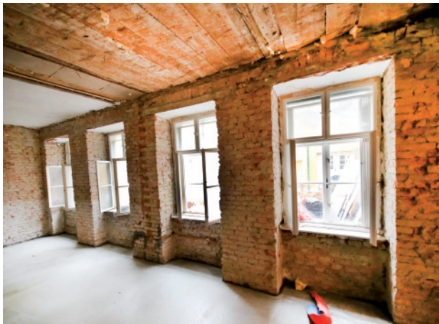
Erneuerung der erdberührten Bauteile
