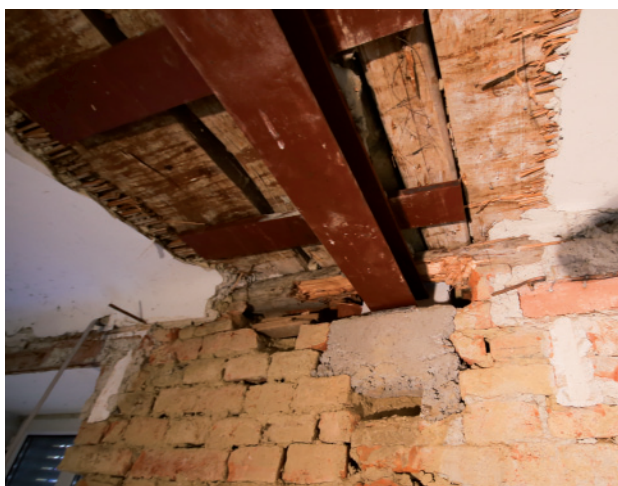
Unterfangung einer Zwischenwand
