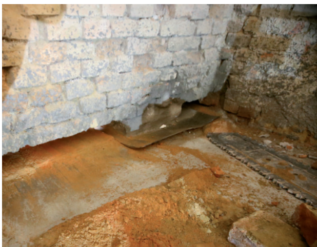
Bei Bedarf Abdichtungsmaßnahmen als vorbereitende Maßnahme
