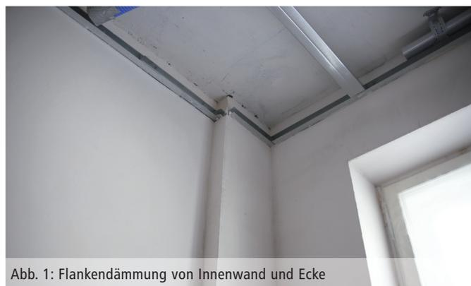
Abb. 1: Flankendämmung von Innenwand und Ecke
