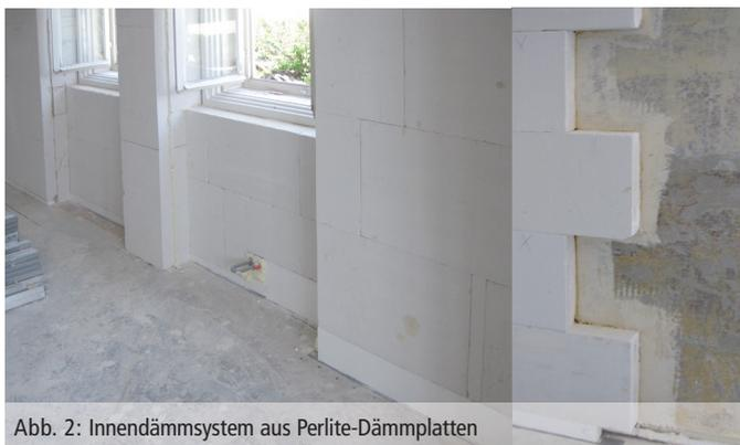
Abb. 2: Innendämmsystem aus Perlite-Dämmplatten
