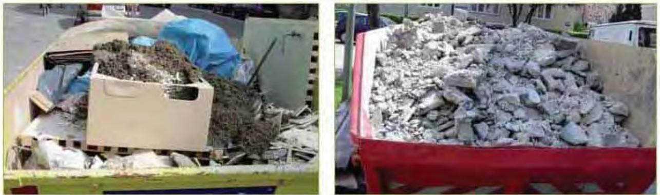
Abb. 3-11 Unsortierter und sortierter Bauabfall
