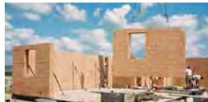
Abbildung 37: Redblock Ziegelfertigteilsystem
