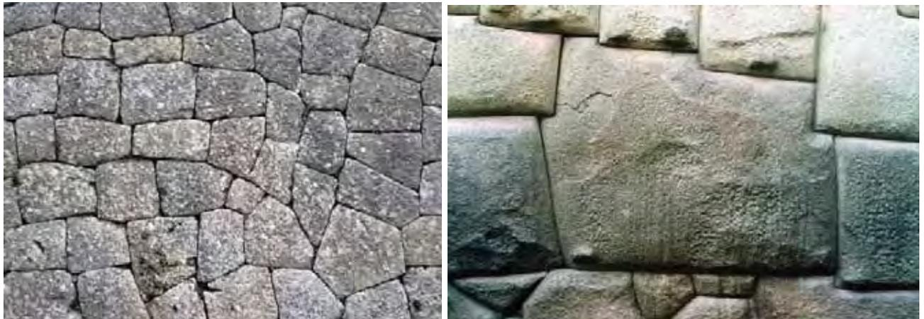
Abbildung 95: Zyklopenmauerwerk
