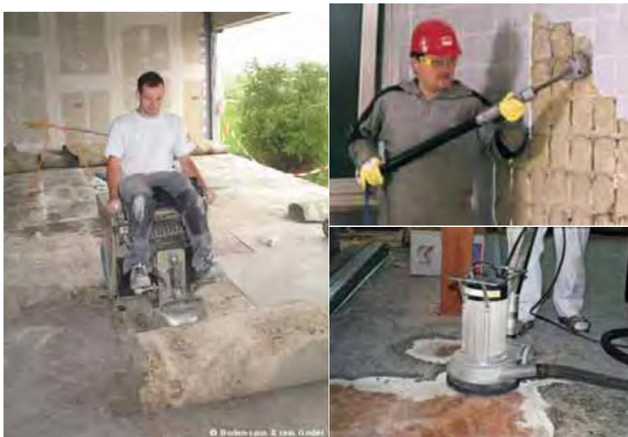
Abbildung 130: Entfernen von Boden- und Wandbelägen. Quellen im Uhrzeigersinn:
