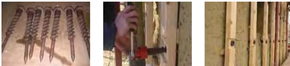
Abbildung 134: S- House: Lattung und Dämmebene sind mit der Schraube fest verbunden und ermöglichen einen wärmebrückenfreien Wandaufbau.
