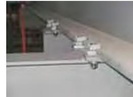
Abbildung 135: BeamClamp Klemmverbindung für Stahlträger
