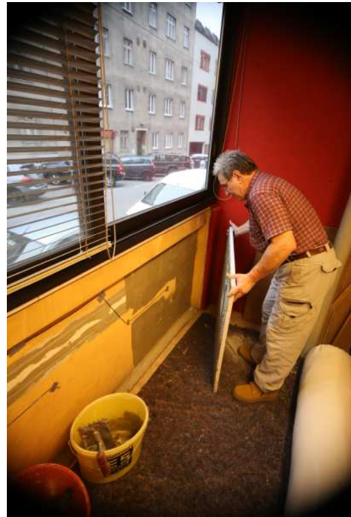
Abbildung 72: Applikation Innendämm-System, Feld 5, Bereich um Messpunkt von Kleber freigehalten.
