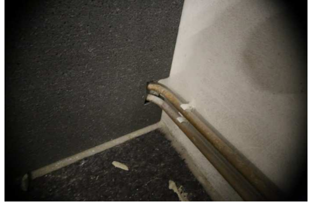
Abbildung 57: Detail Heizungsrohre und Innendämmung
