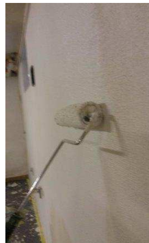
Abbildung 42: Oberflächenbeschichtung, Demonstrationsprojekt aus dem Forschungsprojekt ID solutions, Dämmsystem und Ausführung Projektpartner Sto Ges.m.b.H
