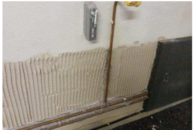
Abbildung 61: Aufbringen der Klebeschicht im Bereich der Heizungsrohre
