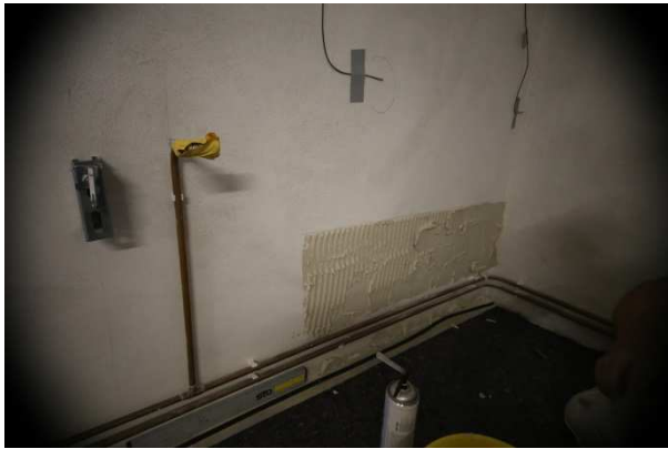
Abbildung 54: Applikation Dämmplatte im Bereich der Heizungsrohre
