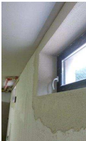
Abbildung 41: Vorbereitung des Untergrunds im Fensterbereich, Demonstrationsprojekt aus dem Forschungsprojekt ID solutions, Dämmsystem und Ausführung Projektpartner Sto Ges.m.b.H
