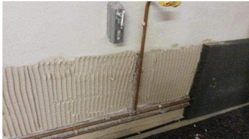
Abbildung 40: Aufbringen der Dämmplatten, Konsole für spätere Heizungsmontage. Demonstrationsprojekt aus dem Forschungsprojekt IDSolutions, Dämmsystem und Ausführung Projektpartner Sto Ges.m.b.H
