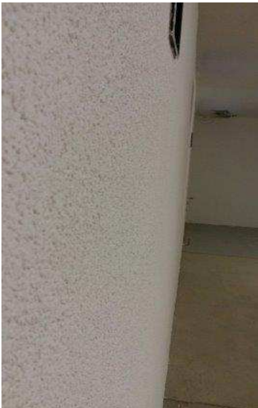
Abbildung 66: Oberflächenfinish des Innendämmsystems
