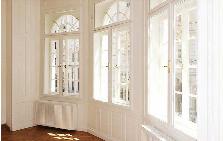
Abbildung 104: Sanierung auf Ebene der Nutzungseinheit mit Wiener Komfort Fenster (Bildquelle und Copyright Wiener-Komfort-Fenster Lux e.U.)
