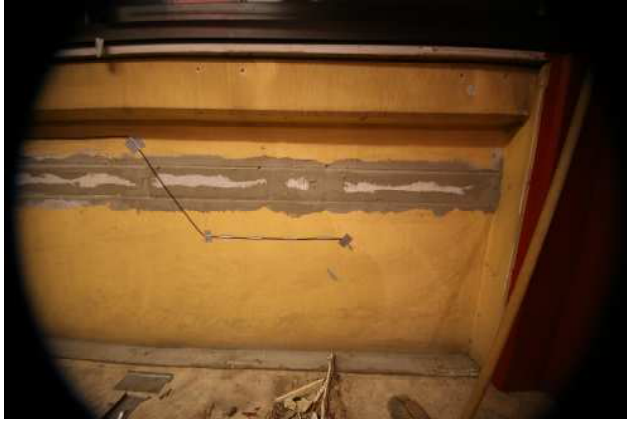
Abbildung 69: Messpunkt zwischen Bestandswand und Innendämmsystem.
