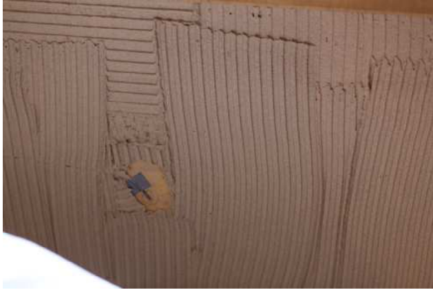
Abbildung 77: Messpunkt Feld 03, Applikation des Dämmsystems, Messpunkt Temperatur und relative Feuchte
