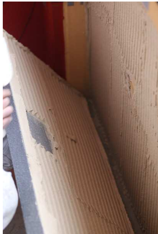
Abbildung 76: Messpunkt Feld 01, Bereich um Sensor von Kleber freigehalten.
