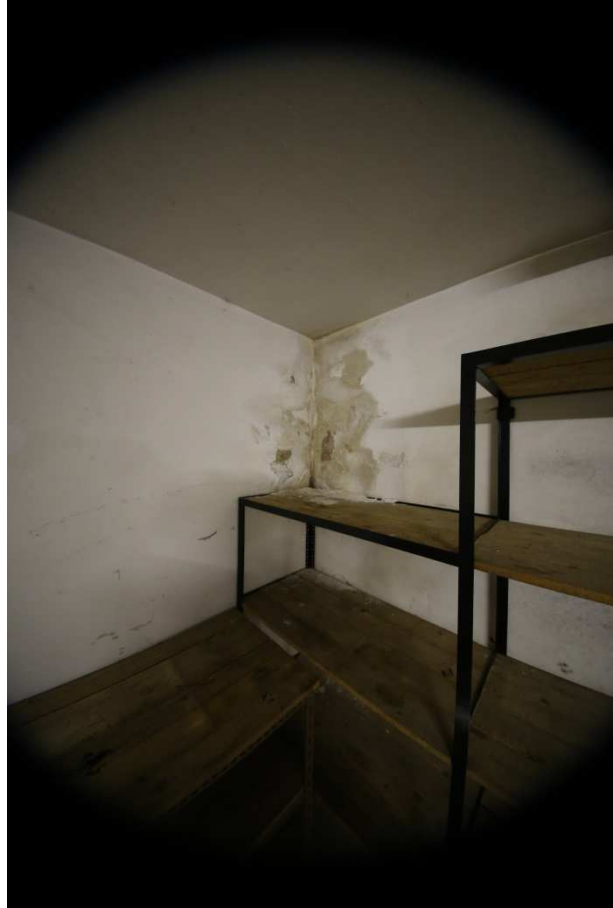
Abbildung 46: Feuchteschaden durch eindringendes Oberflächenwasser.
