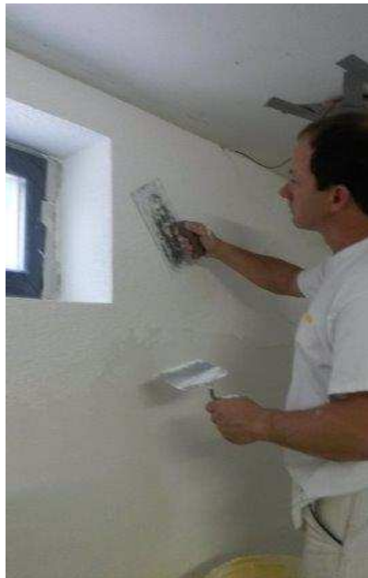
Abbildung 67: Aufbringen der letzten Putzschicht des Innendämmsystems
