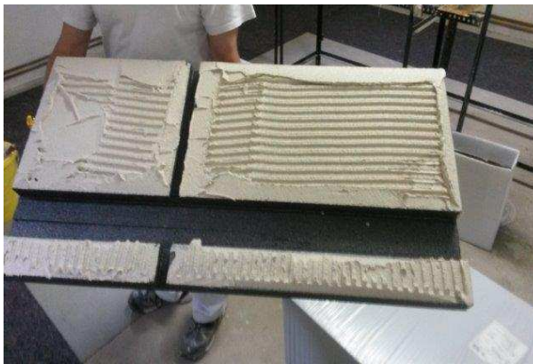
Abbildung 58: Dämmplatte mit Kleberschicht, für Heizungsrohre ausgeschnitten.
