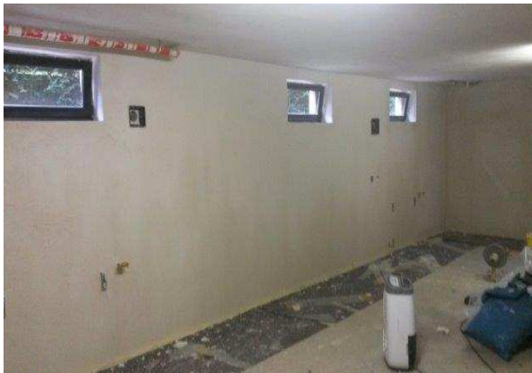
Abbildung 60: Kellerwand nach Aufbringen des Grundputzes
