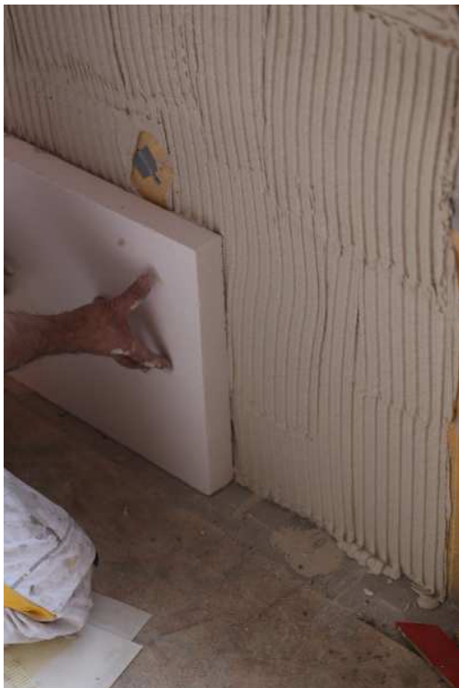
Abbildung 79: Messpunkt Feld 02, Applikation des Dämmsystems, Messpunkt Temperatur und relative Feuchte
