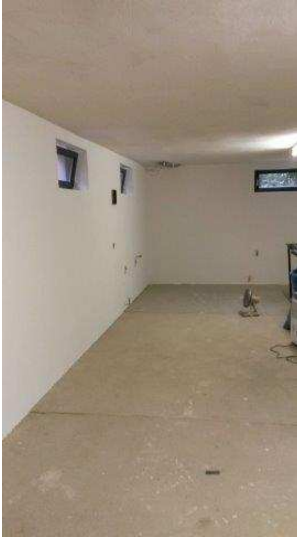
Abbildung 62: Sanierungsobjekt nach Fertigstellung der Innendämmung
