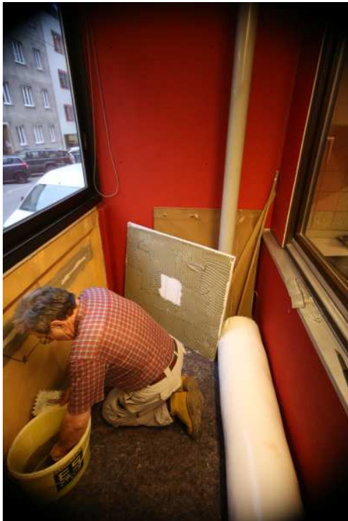
Abbildung 71: Applikation Innendämm-System, Feld 5, Bereich um Messpunkt von Kleber freigehalten.
