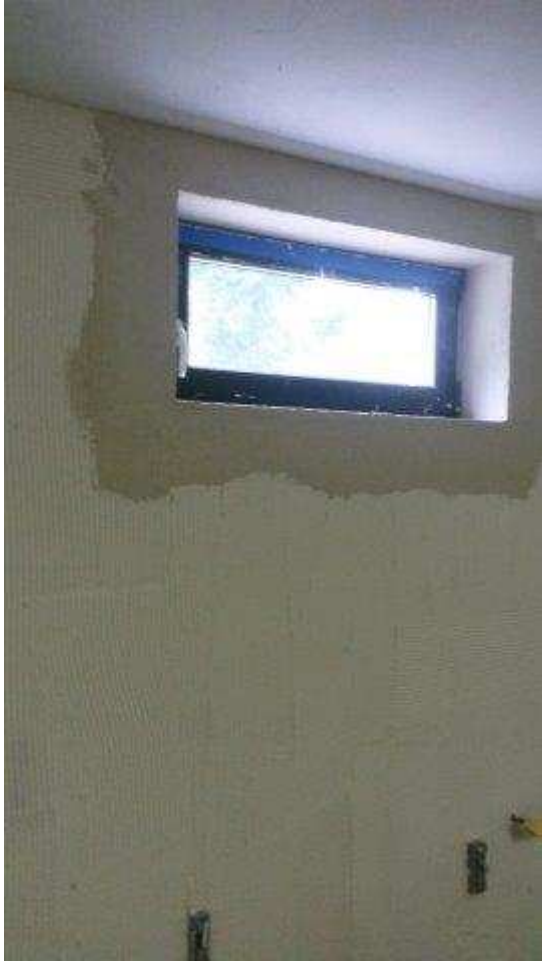
Abbildung 51: Fenstertausch und Vorbereitung der Leibung
