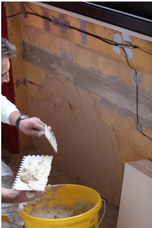
Abbildung 75: Messpunkt Feld 01, Applikation des Dämmsystems, Messpunkt Temperatur und relative Feuchte
