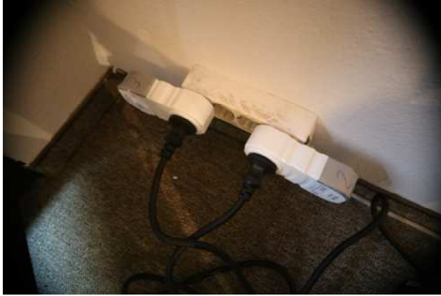
Abbildung 81: Funkgesteuerte Schaltaktoren zur Steuerung von Heizregister, Ventilator und Luftbefeuchter
