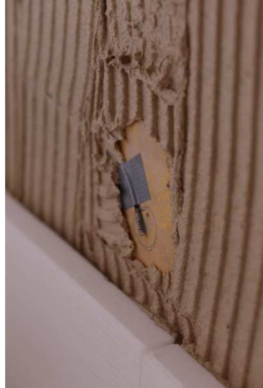
Abbildung 78: Messpunkt Feld 03, Applikation des Dämmsystems, Messpunkt Temperatur und relative Feuchte
