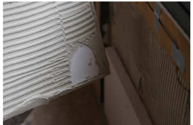
Abbildung 80: Messpunkt Feld 02, Applikation des Dämmsystems, Messpunkt Temperatur und relative Feuchte
