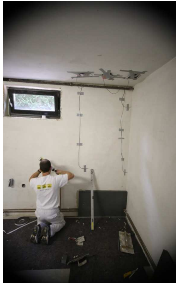
Abbildung 63: Applikation der ersten Dämmplatten, Mess-Sensoren positioniert, Kabel werden im Deckenbereich hinter der Dämmung herausgeführt.
