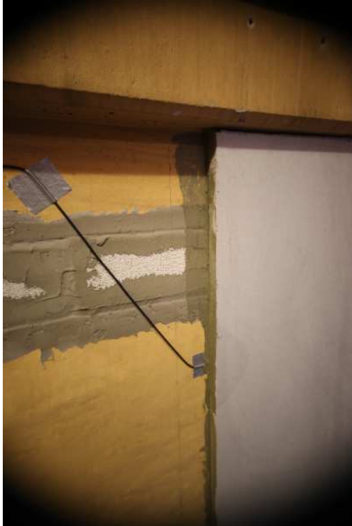
Abbildung 73: Innendämm-System Feld 05, Kabel des Sensors wird seitlich herausgeführt.
