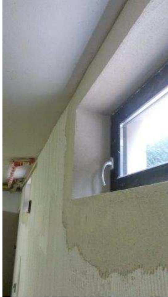
Abbildung 52: Glattstrich im Bereich der Fenster
