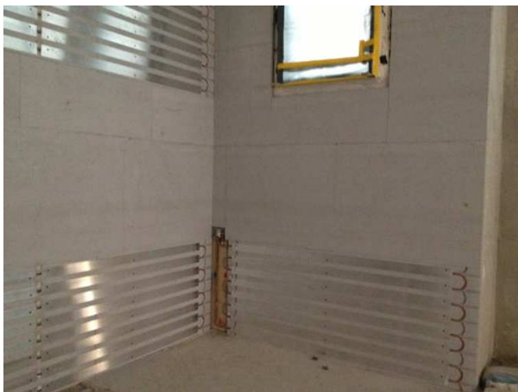
Abbildung 116: "Feuchteregulierende Klimaplatteninnendämmung in einer Ebene mit Wand Heiz- und Kühlsystem."
