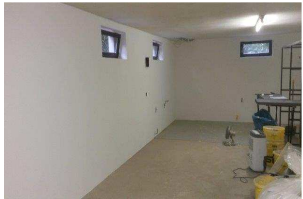
Abbildung 59: Keller nach Fertigstellung der Innendämm-Maßnahme.
