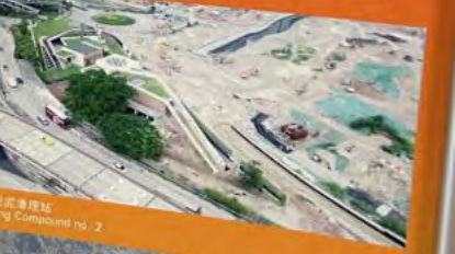
二號淤泥清理站 Desludging Compound no. 2
