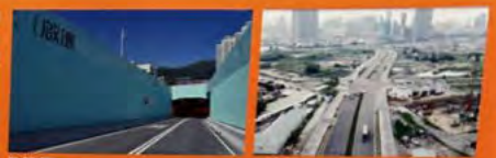
新幹道 Kai San Road 承啟道 Shing Kai Road
