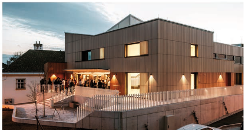
Der Eingangsbereich vorher und nachher
