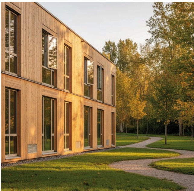
Abb. 1: Holz als dominierendes Baumaterial
