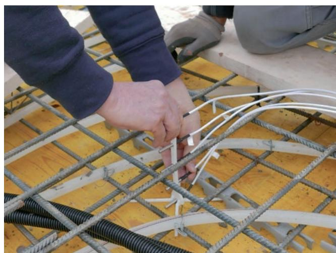
Einbau der Leitungen für die Bauaktivierung und anbringen der Messfühler, Fotos ©: Treberspurg & Partner Architekten
