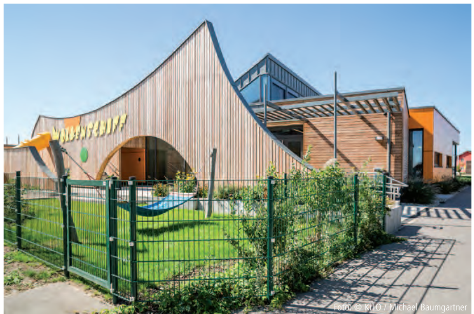
Abb. 4: Wolkenschiff ein Kindergartenneubau in Passivhausstandard in Gänserndorf Süd ausgezeichnet mit dem klima:aktiv-Gold-Standard, gebaut vom Atelier für naturnahes Bauen Deubner.
