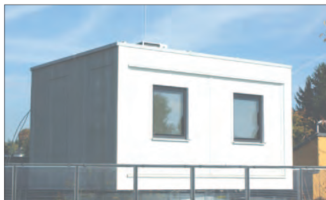
Die drehbare fertige Fassadenbox mit der Standardfassade auf dem Dach des Prüflabors der AEE INTEC in Gleisdorf
