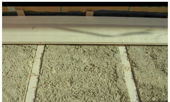
Lehmestrich mit Polsterhölzern im Dachbodenausbau, Foto: © Andi Breuss
