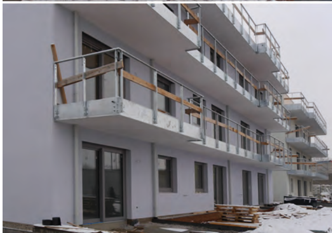
Baustelle Tulln: Abstimmung aller Fassadenelemente, Strukturierung des Baukörpers sowie Einbindung in die stark farbige, kleinteilige Umgebung. at home Immobilien-GmbH, Arch. Achtsnit. © Archicolor, P. A. Buxbaum
