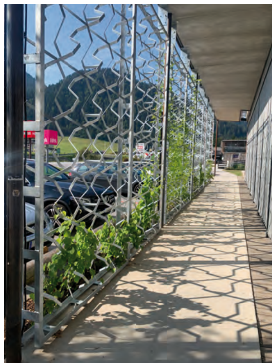
Rankgerüste montiert, erster Bewuchs, Foto ©: MPREIS
