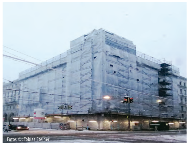
Abb. 4: Baustelle im Winterbetrieb
