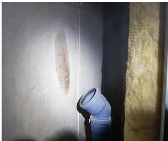
Kanalgeruch aus einer offenen Rohrleitung, Foto ©: Innenraumanalytik OG
