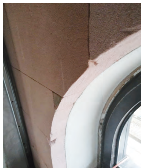
Abb. 7: Ausbildung Innendämmung an halbrunden Fensterelementen vor Applikation der Leibungsdämmung
