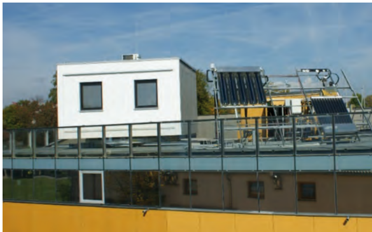
Abb. 2: Fassadenprüfbox der AEE INTEC; Außenaufnahme und Grundriss
