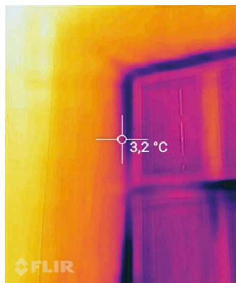
Abb. 6: niedrige Oberflächentemperaturen im Leibungsbereich bei Anschluss Fenster
