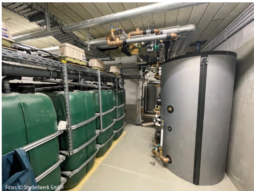
Fotos ©:Strebelwerk GmbH
