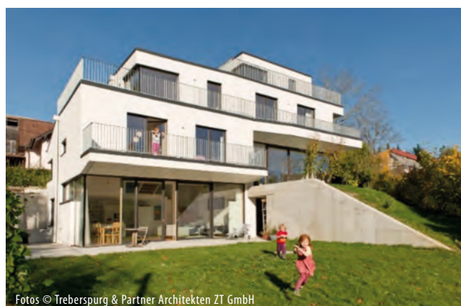
Abb. 1: Das Demogebäude Doppelhaus in Purkersdorf
