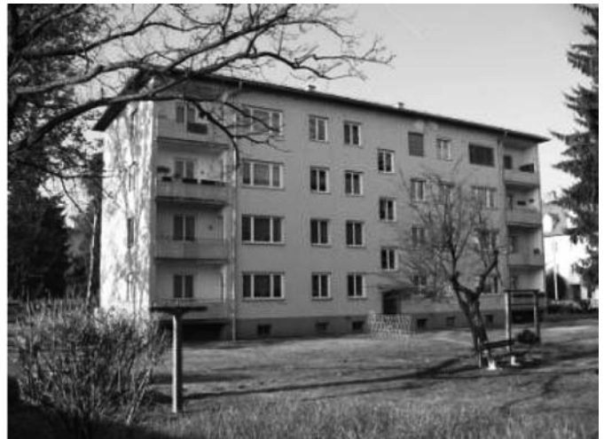
Abb. 1: Projekt Dieselweg 10, 12, vor der Sanierung
