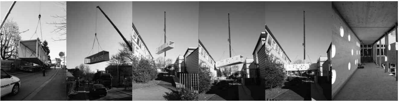
Abb. 6: Einbringen der Verbindungsbrücke, Fotos: © grundstein
