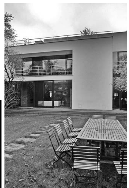
Abb. 5: Jahrhundertwende-Haus, Gartenfassade vorher – nachher (Dämmung, Passivhausschiebefenster, neue Terrasse – privater Freiraum etc.)
