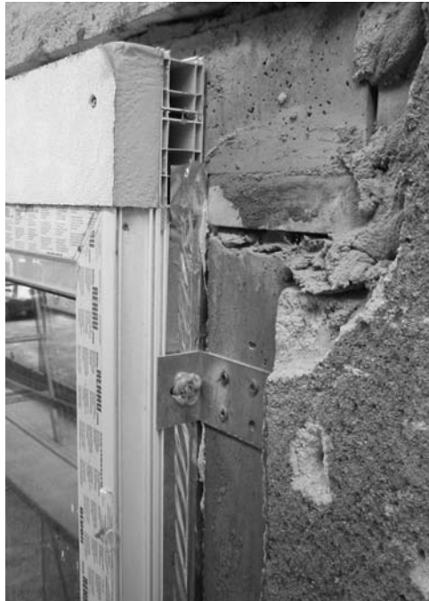
Abb. 11: Kantholz als Auflager für die Fenster. Diese Lösung ist auch baupraktisch optimal, da so das Auflager einfach nivelliert und das Fenster anschließend zur Montage darauf abgestellt werden kann. Die Befestigung mit Winkeln seitlich geschieht additiv. Die Wärmedämmung (graue Blöcke) wird anschließend auf den alten Außenputz geklebt und wenn nötig zusätzlich gedübelt. [15]
