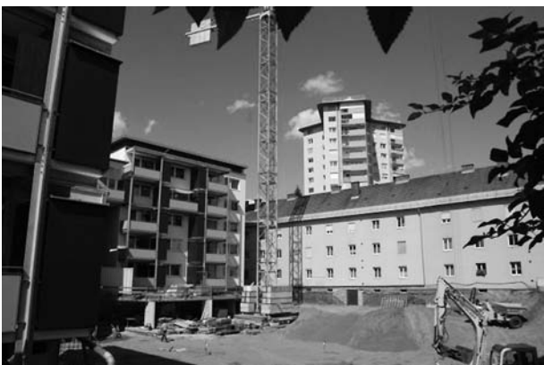
Abb. 6: Wohnhausanlage Luegerstraße/Ginzkeygasse – Abbruch und Neubau (Foto: Fortschritt)
