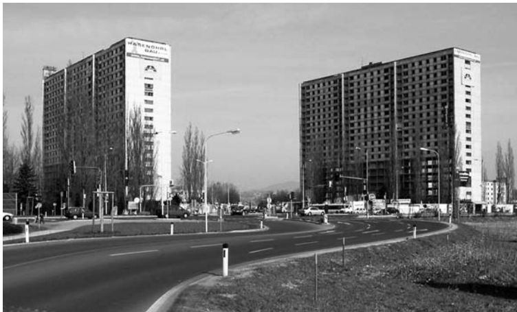
Abb. 1: Wohngebäude am Harter Plateau am Tag vor der Sprengung (Foto: Dralon)
