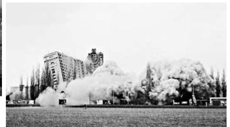
Abb. 2+3: Sprengung der beiden Wohnhäuser am 13. April 2003 (Fotos: Wurnig)
