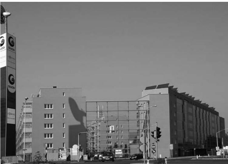
Abb. 5: Wiederbebauung Harter Plateau (Foto: GIWOG)
