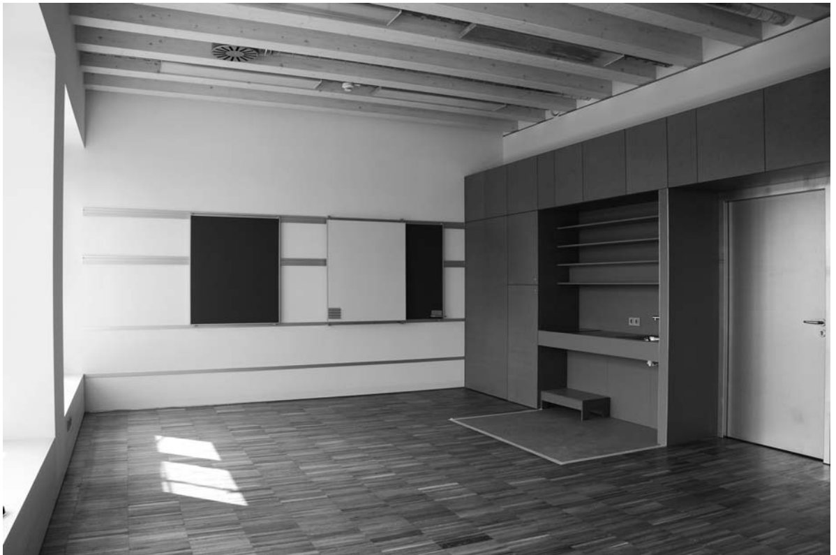
Abb. 9: Klassenraum im Dachgeschoß mit HBV-Deckensystem Foto: © grundstein
