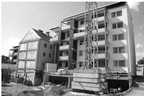
Abb. 7: Wohnhausanlage Luegerstraße/Ginzkeygasse – Abbruch und Neubau (Foto: Fortschritt)
