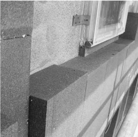
Abb. 11: Kantholz als Auflager für die Fenster. Diese Lösung ist auch baupraktisch optimal, da so das Auflager einfach nivelliert und das Fenster anschließend zur Montage darauf abgestellt werden kann. Die Befestigung mit Winkeln seitlich geschieht additiv. Die Wärmedämmung (graue Blöcke) wird anschließend auf den alten Außenputz geklebt und wenn nötig zusätzlich gedübelt. [15]
