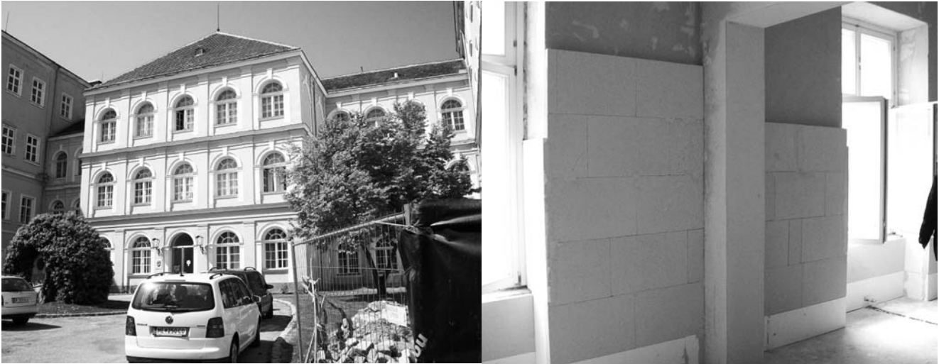
Abb. 3+4: Sanierung des Patres- trakt mit YTONG Multipor Innen- dämmung.
