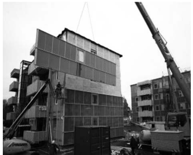
Abb. 3: Anbringen der vorgefertigten Fassadenelemente
