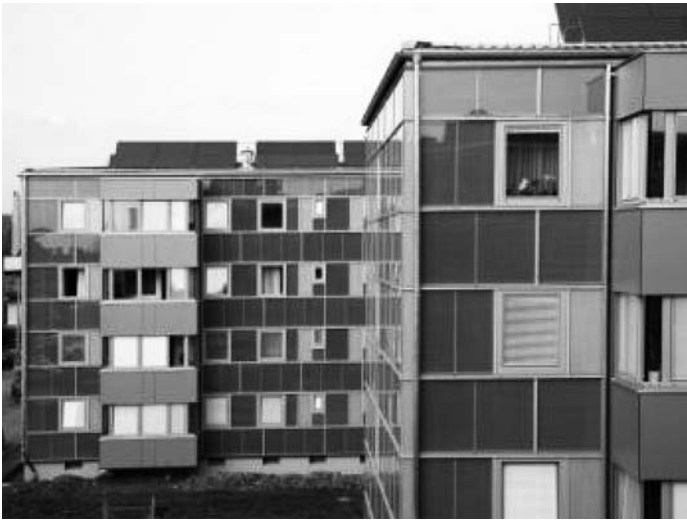
Abb. 5: Projekt Dieselweg 10, 12, nach der Sanierung
