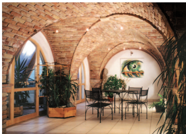
Ziegelgewölbe © Verband Österreichischer Ziegelwerke
