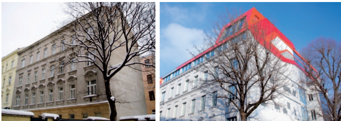
Abb. 2: Objekt Wißgrillgasse vor und nach umfassender Sanierung und DG-Ausbau (Fotos: Ulreich, Gassner & Partner)
