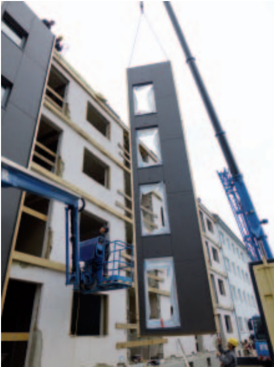
Abb. 2: Montage der Fassadenfertigteile (Quelle: AEE INTEC) Fig. 2: Mounting of the prefabricated façade elements (Source: AEE INTEC)
