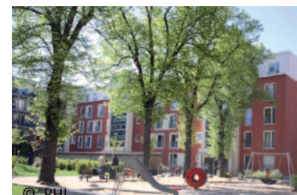
Abb. 7: Frontrunner Frankfurt/M.: Geschoßwohnungsbau Sophienhof
