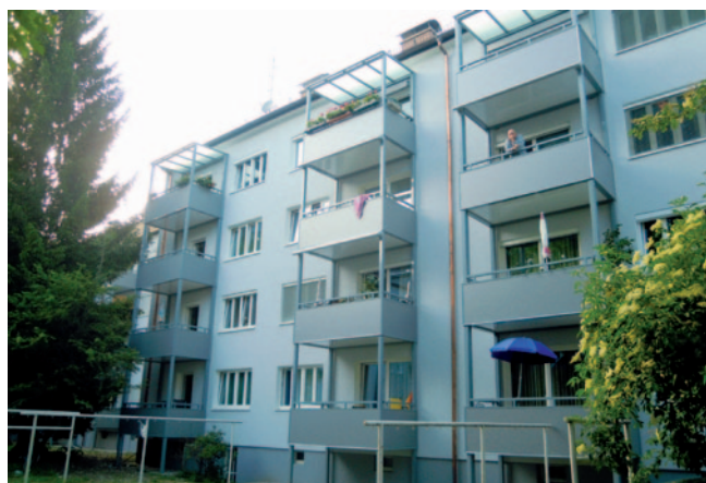
Alle 14 Häuser mit 285 Wohnungen wurden thermisch saniert und erhielten Balkone
