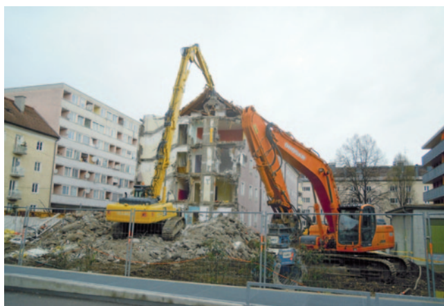
Neubauetappe: Abbrucharbeiten abgeschlossen, Baubeginn Herbst 2013
