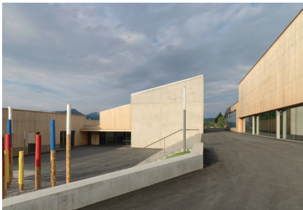
Mittelschule Doren - Außenansicht; Foto: Robert Fessler
