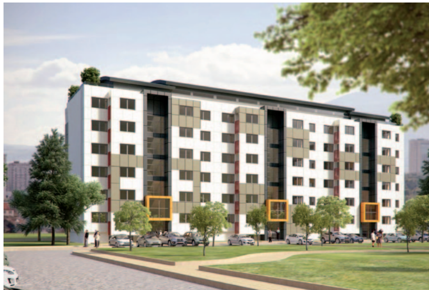
Abb. 4: Integriertes Fassadensystem (hinterlüftet, mit Sonnenblenden, Klimaanlagen etc.) und wärmeisolierte Fassaden mit selbstreinigendem Verputz für blinde Mauern)
