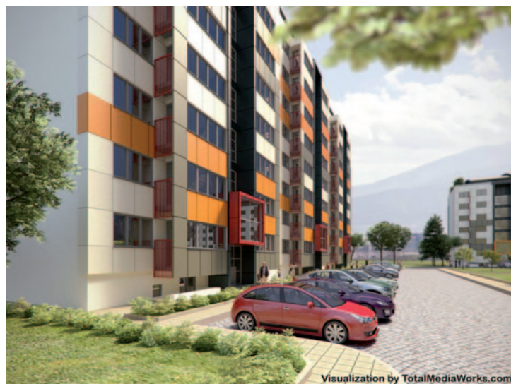
Abb. 3: Installation von Balkonen und Verschluss der Loggien zur Schaffung von „Wintergärten“
