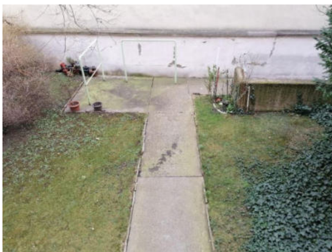
Abbildung 8-30: Gemeinsamer Innenhof der Friedrich-Kaiser-Gasse 26 und 28
