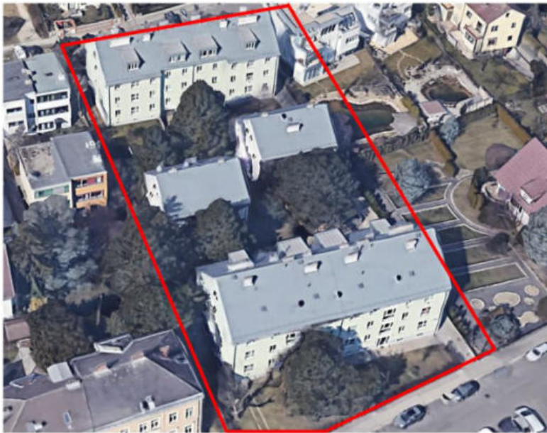
Abbildung 10-106: Ansicht, Bergheidengasse 18-18A, 1130 Wien (Quelle: Google Maps © 2024 Google)
