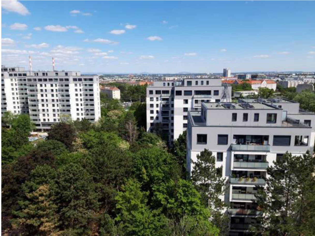
Abbildung 14-50: Das Sanierungsgebäude Hauffgasse © bwsg
