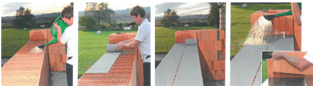
Abb. 1: Arbeitsschritte zur Erstellung des Mörtelbandes: Vorwässerung der Ziegel, Ausrollen des trockenen Mörtelbandes, ausgerolltes Mörtelband auf Ziegelmauerwerk, Wässern des Mörtelbandes, Mauern auf das feuchte Mörtelband
