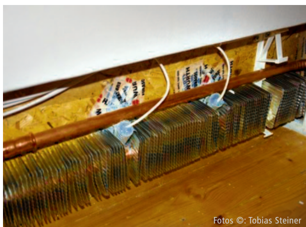
Abbildung 4: Heizleiste, Durchführung der Kabel der Balkenkopfheizung durch die Dampfbremsebene
