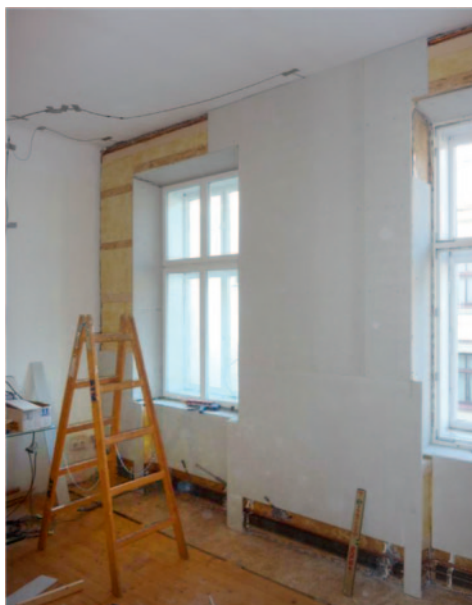
Abb. 2: Beplankung der Installationsebene
