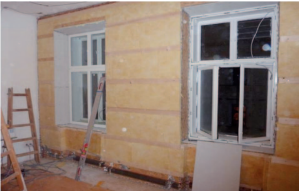
Abb. 1: Fertigstellung Mineralwolle-Dämmung der Installationsebene
