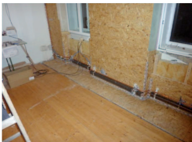
Abb. 3: Ausführung Heizleiste
