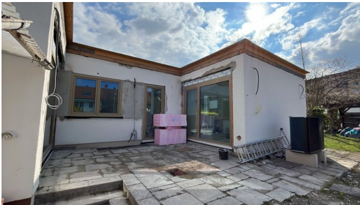
Abbildung 59: Baustelle der Bestandssanierung (Bild: Fröhlich)
