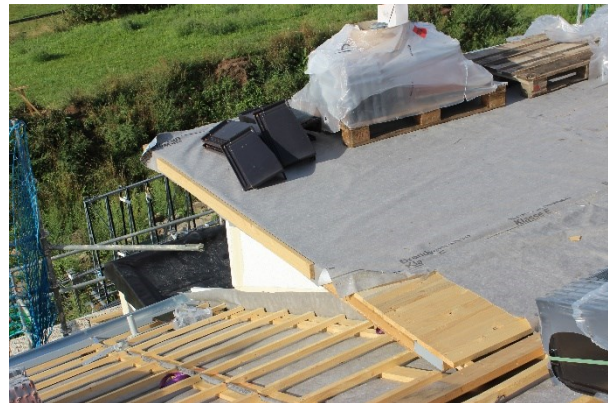
Abbildung 2: Dacheindeckung mit Kunststoffanteilen: u.a. Kunststofffolien, EPDM-Abdichtung und Kunststoffverpackungen für Tonziegel, (Bild: Hochschule München)
