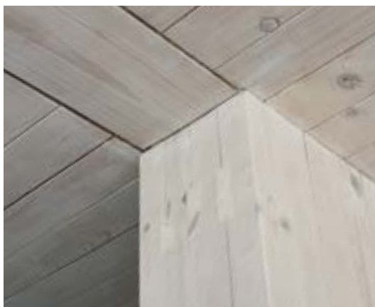
Abb. 1.23 Massivholzbau MaxAcht in Stuttgart
